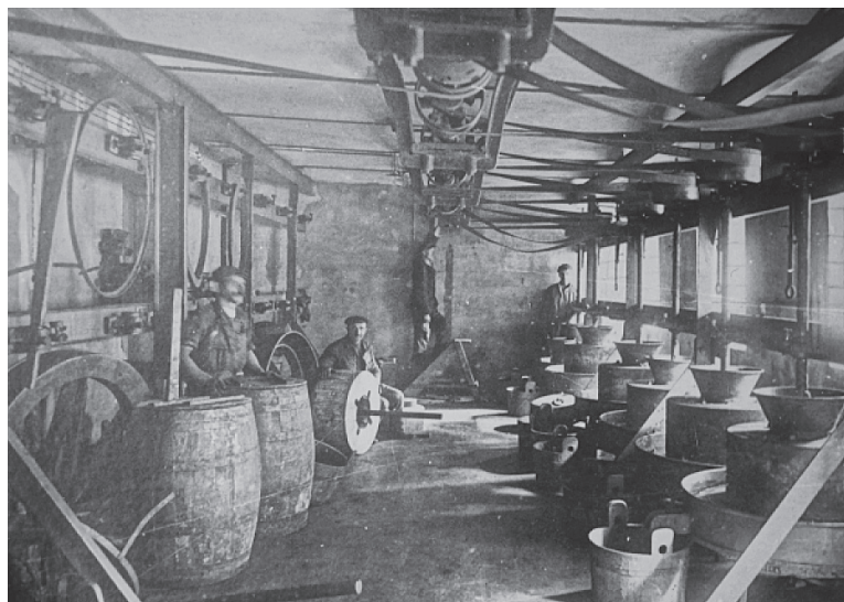
Młyny żarnowe do ucierania masy grafitowej (1910–1914). Z lewej strony beczki służące do uprzedniego szlamowania glinki
