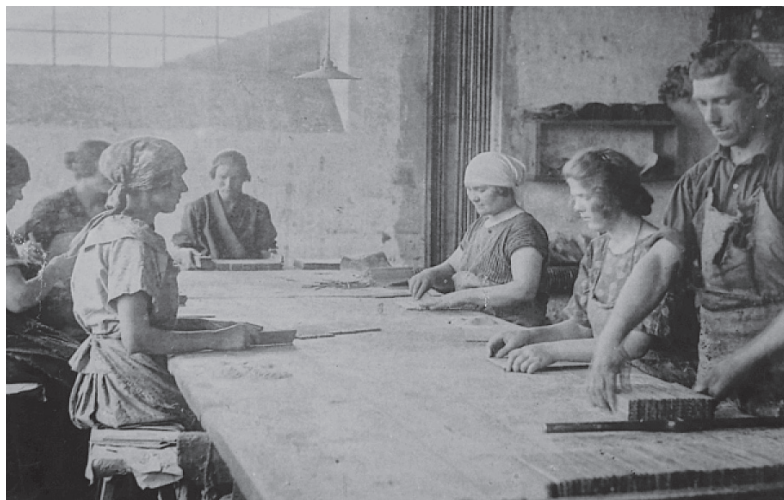
Klejnaria. Pręciki wkleja się w dwie deseczki i zaciska w specjalnym ścisiku
