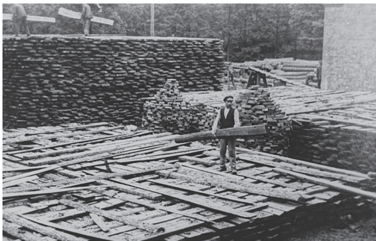
Układanie bali w sztaple dla sezonowania na wolnym powietrzu
