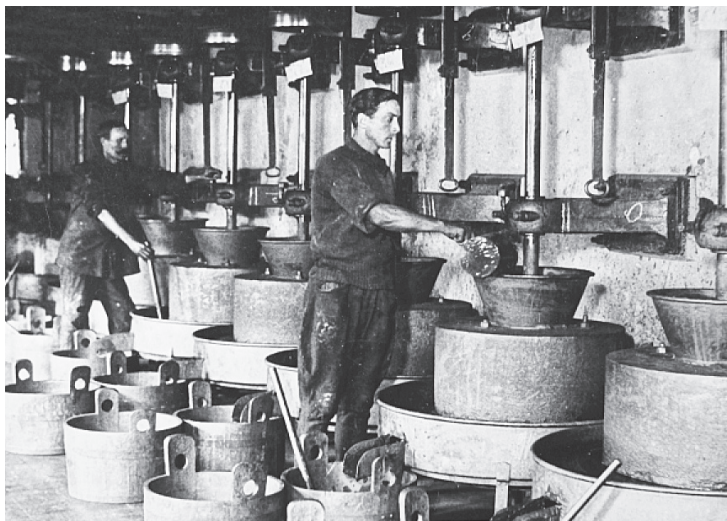
Obsługa młynów żarnowych dla mas grafitowych „Polonia”. Masa ucierana była przez dwa tygodnie (lata trzydzieste XX wieku)
