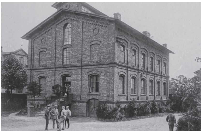
Budynek biur, stąd wychodziły instrukcje
