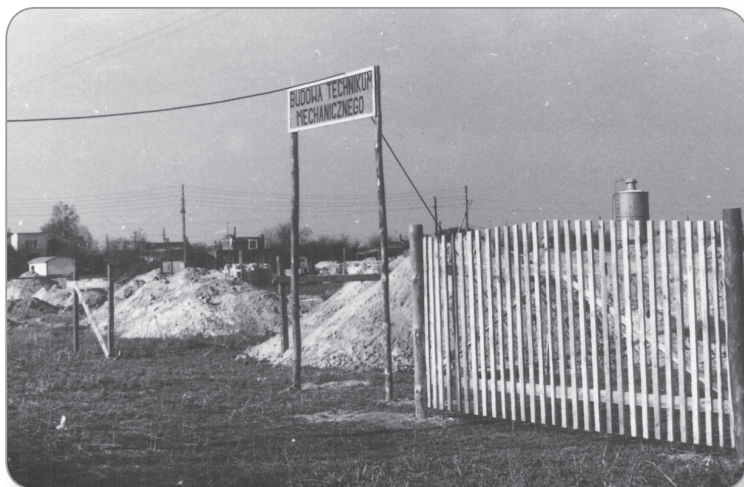
Budowa Technikum Mechanicznego na ul. Krańcowej, rok 1964
